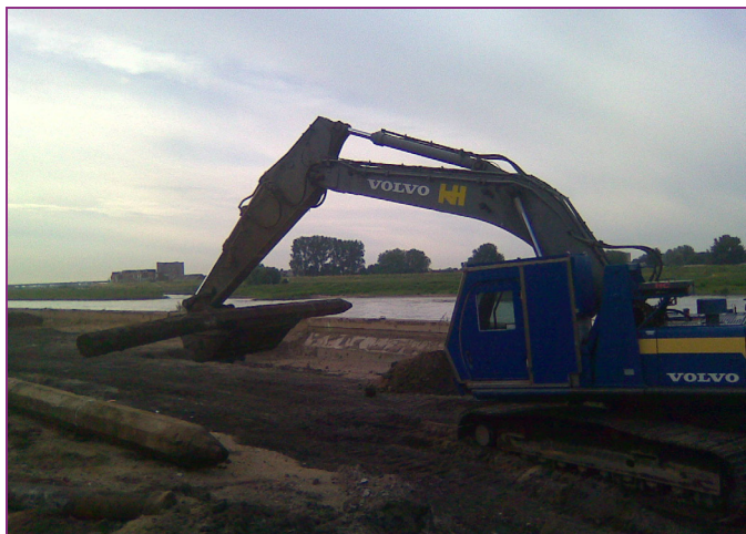
Afbeelding 34. Het verplaatsen van aangetroffen betonpalen met gepantserde graafmachine.
